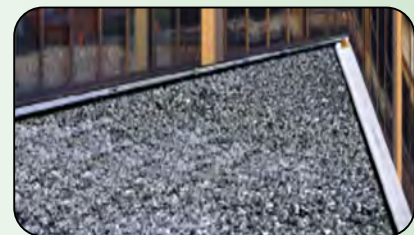
Flachdachdämmung mit loser Schüttung
