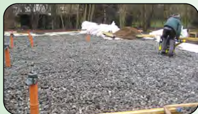
Baugrube mit bi-foam als wärmedämmende Gebäudesohle
