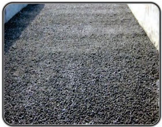
Fundament in Kombination mit bi-foam Schaumglas verdichtet
