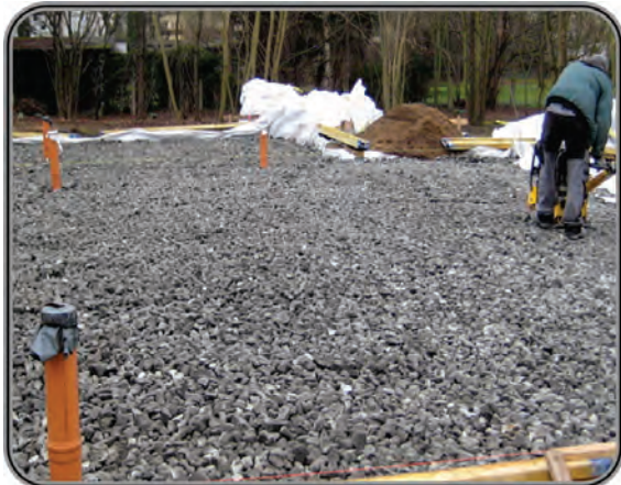
Baugrube mit bi-foam Schaumglas als wärmedämmende Gebäudesohle
