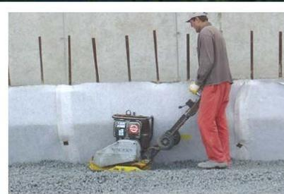
Bild 8: Verdichtung direkt am Widerlager
