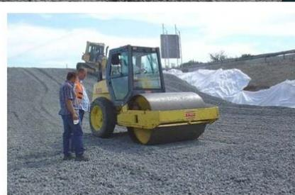
Bild 7: Verdichtung mit der Walze
